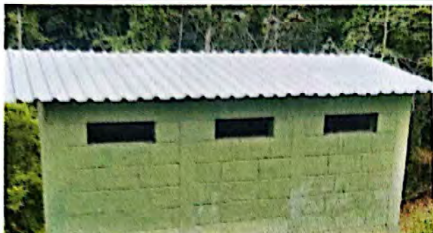
Foto 1: Entrechado nuevo con lámina troquelada para los sanitarios del establecimiento educativo.
