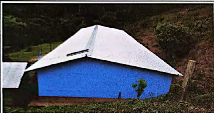
Foto 3: Vista panorámica del techo nuevo instalado con láminas troqueladas en el centro educativo.
